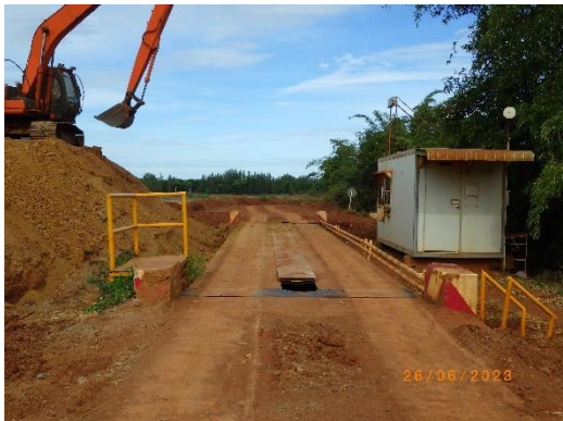
รูปที่ 2-15 จุดล้างน้ำหนักรถบรรทุกก่อนออกภายนอกพื้นที่โครงการฯ
